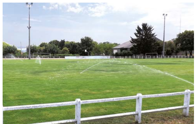
Le manque de pression et de débit dans l'installation est le signe d'un arrosage intégré défectueux. ©F.LUCAS, FREDON AURA
