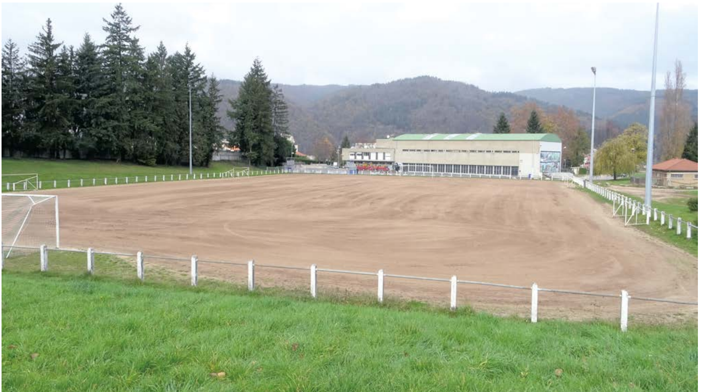
L'entretien courant d'un terrain en stabilisé consiste à passer avec une herse pour uniformiser la surface de jeu et supprimer les adventices. Ici à Aurec-sur-Loire (43), commune labellisée Terre Saine et engagée dans la Charte d'Entretien des Espaces Publics. ©F.LUCAS, FREDON AURA
