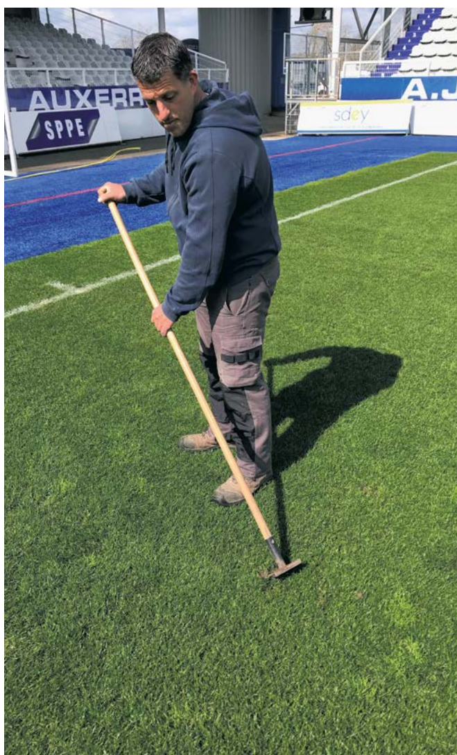
La réparation du terrain après un match ou un entraînement peut se faire à l'aide d'un râtelier pour remettre les plaques de gazon arrachées à leur emplacement initial ©C. BENOIST
